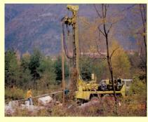
$R_E$ : valore iniziale 2,61  $\Omega$   $R_E$ : valore dopo infissione di due dispersori da 110 m e 124 m: 0,463  $\Omega$
